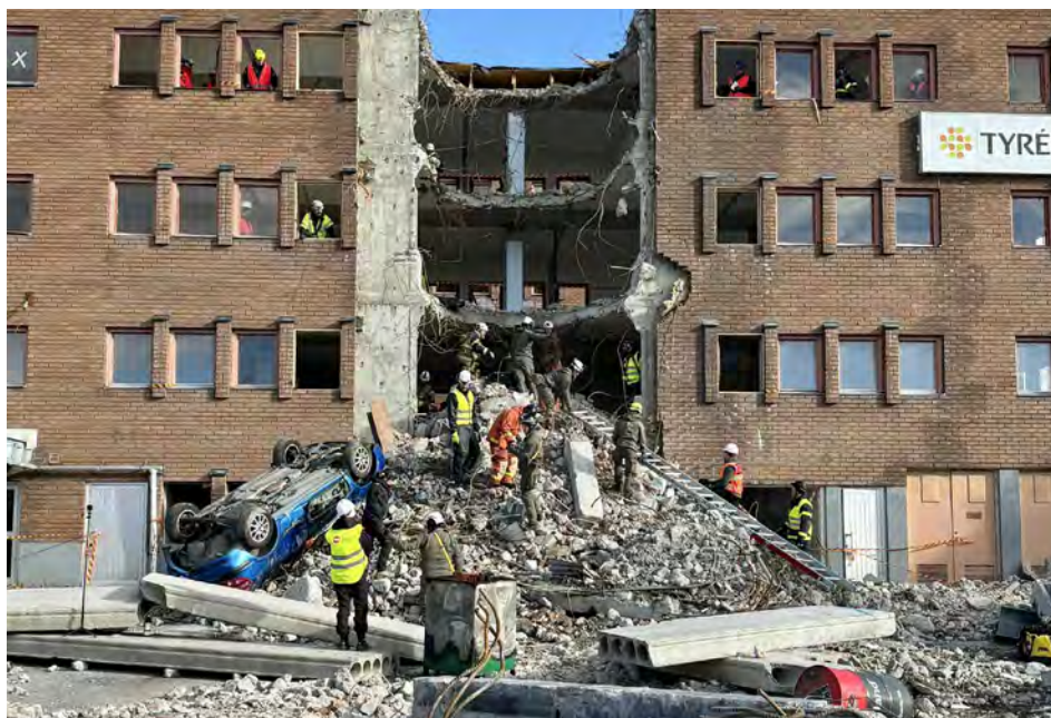
Metodförsök i Kiruna: Räddningstjänster från hela Sverige övar i rivningsbyggnader som förvandlats till en fiktiv krigszon. Foto: MSB.
