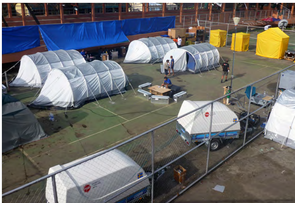
MSB-styrkan byggde detta basläger på en idrottsplats i den hårt drabbade staden Tacloban. Campens huvudsyfte var att ge personal från FN drägliga arbetsförhållanden (kontor) och boende. Foto: MSB, Björn Svärd.
